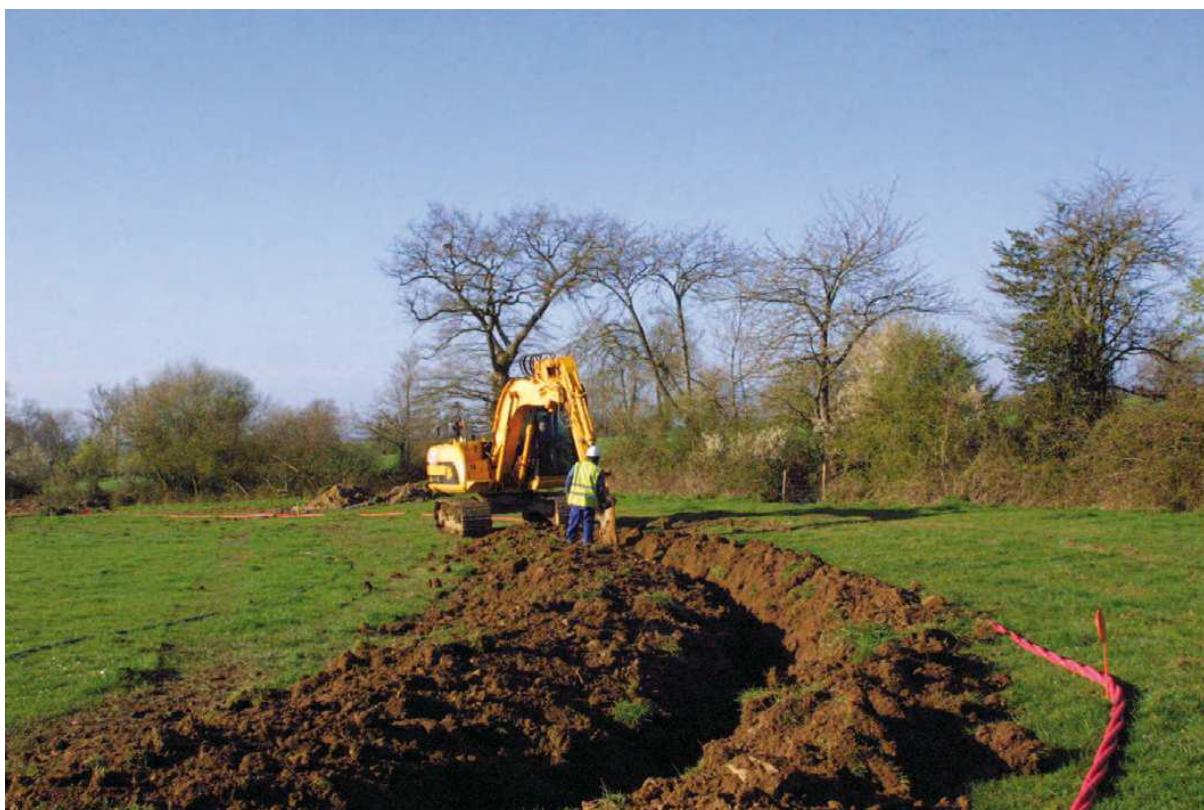
Cf. : Figure 98 : Enfouissement de lignes électriques
